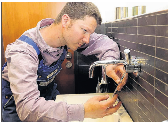
...und kleine Reparaturen im Bad gehören zum Repertoire der Firma „Steup“. Fotos: Rick (1), privat
